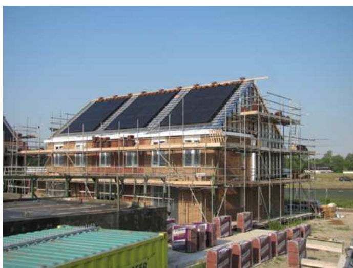
Fig. 4.1 Rijswijk Buiten (nieuwbouw) [15]
