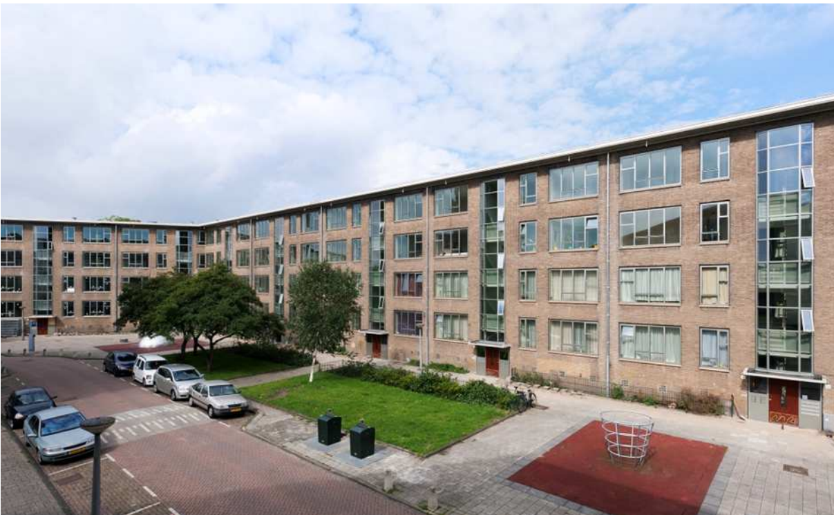
Fig. 8.10 De Koningsvrouwen van Landlust is een renovatie- en restauratieproject in de Amsterdamse wijk Bos en Lommer.
